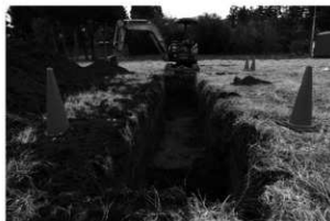
4 トレンチ調査状況(東から)
