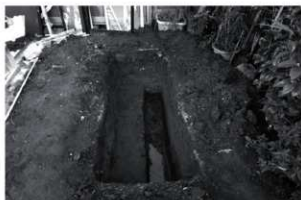
3 Bトレンチ(西から)
