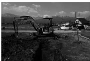
7 B トレンチ (東から)
