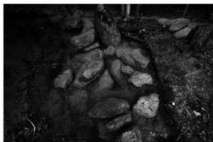
4 左側壁 (南から)
