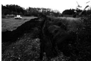
8 完掘状況（南から）
