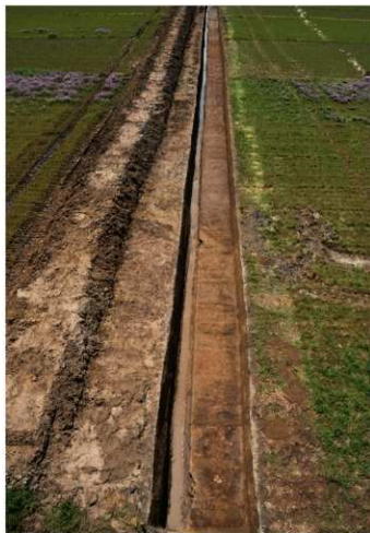
写真7 7区道構検出状況 -北から-
