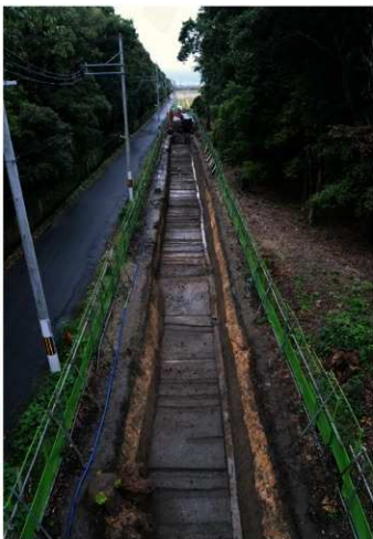
写真21 上層道橋完掘・下層道橋検出状況 - 東から -
