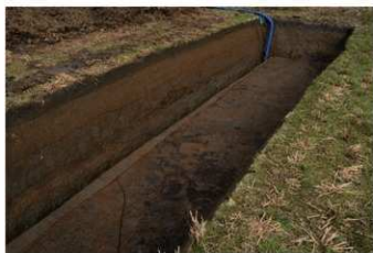
写真10 2001SD 検出状況 -南東から-
