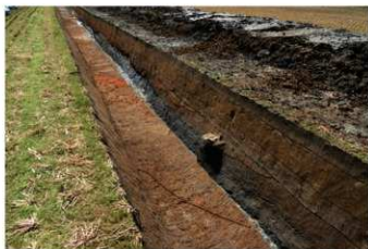
写真11 2002SD 北研検出状況 -北北東から-
