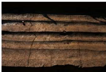
写真44 013SD 検出状況 -北から-
