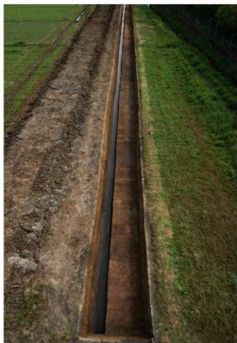
写真6 6区道構検出状況 -北から-
