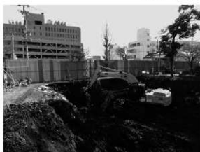
校舎解体工事（北西から）
