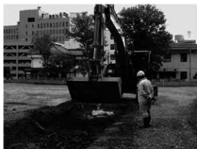
平成27年度調査表土掘削状況
