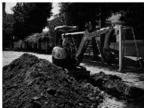
試掘調査状況
