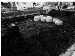
後町ホール雨水貯留槽撤去状況（北西から）
