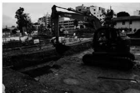
平成28年度調査表土掘削状況
