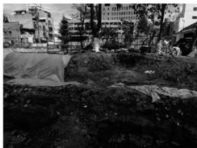
平成28年度中央棟工事立会い状況
