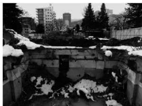
校舎地下室遺存状況（東から）
