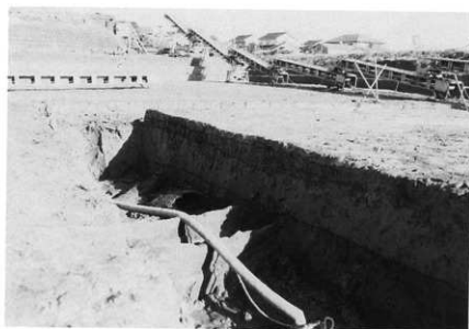
1 | 区調査区中央部 6層以下土層堆積状況
