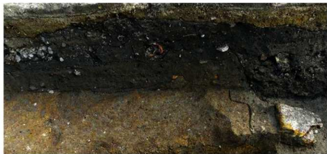
DA第137・140次調査 大安寺講堂 西面延石列と基礎造成土 (南から)
