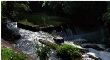
図5 取水堰と取水口
