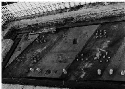
4区全景（西半部）
