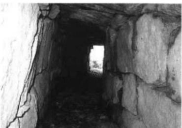
fig. 50 平場1 滞壺南側暗渠排水口
