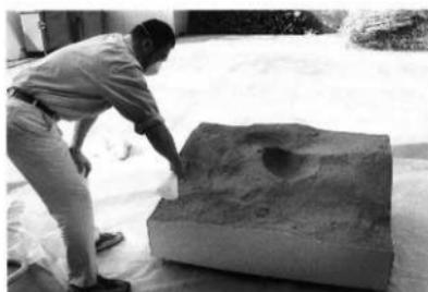
fig. 314 土壌強化剤(OH100)散布作業
