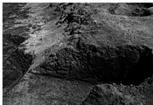
C084SZ 南東法面の硬化部 (南西から)
