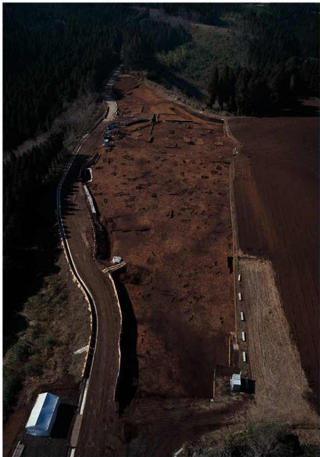
定塚遺跡全景（南西上空から）
