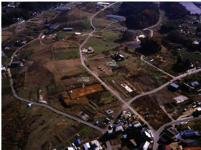
▲ A・B地点の間、丘陵中央の平坦面を道路(写真中央)が通る。
