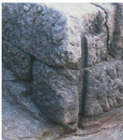
放水口の堰板溝、上部に四角い切り込み
