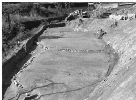
3. 2次3区全景 (南東から)
