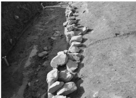
3. 2次3区2石垣中央部付近 (南東から)
