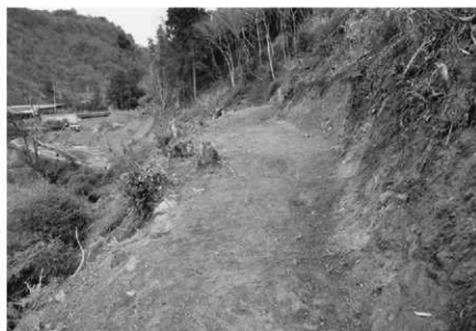
2. 2次4-1区中央部掘削完了状況 (南から)
