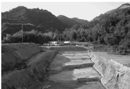
2. 1次1-1区全景(南から)
