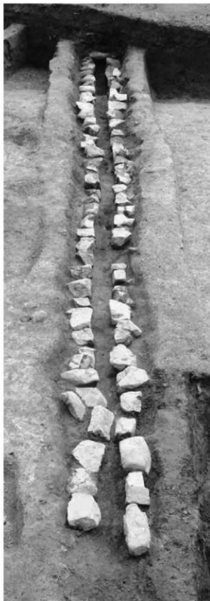
2. 1次2・2区 203 暗渠蓋石除去後 (北西から)
