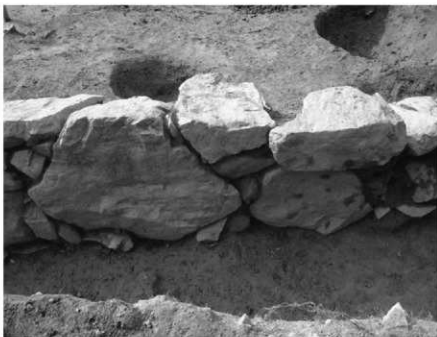
2. 1次2-1区331石垣石積細部(南東から)
