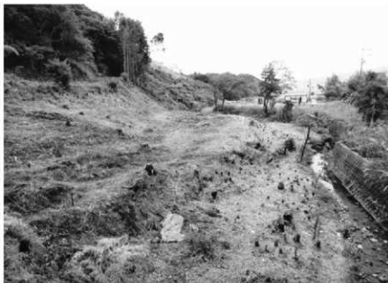
3. 2次3区草刈後の状況（北から）
