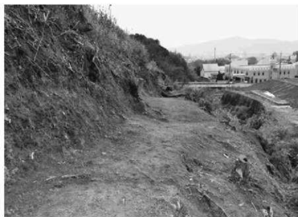
3. 2次4-1区南側掘削完了状況 (北から)
