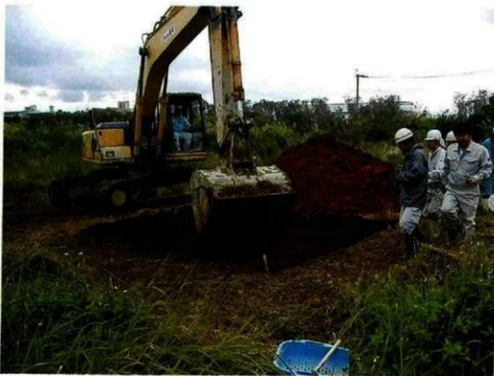
図版6 作業風景 重機による掘り下げ作業
