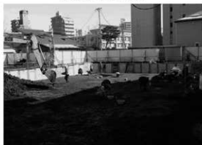
作業風景 (A区2次面)
