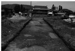
1区平安時代遺構（南から）
