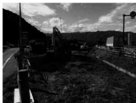
写真1 1次面表土掘削作業(8月11日)
