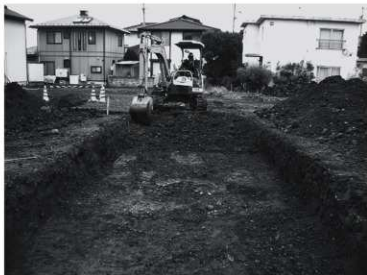
重機掘削状況
