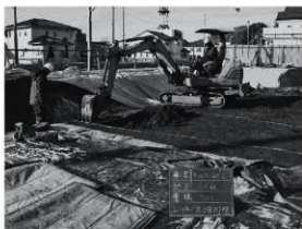
写真1 表土掘削作業 (1月27日)
