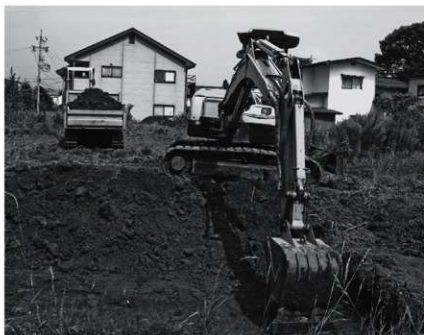
重機表土掘削
