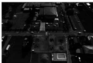
調査地遠景 (北から)
