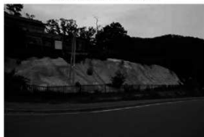
モルタル吹付工事施工後（南西から）
