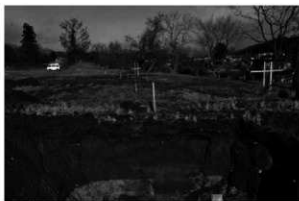
A区（南から）
