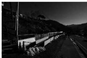
モルタル吹付施工面（西から）
