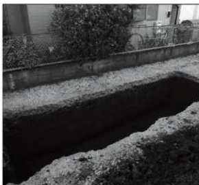
3. 完掘 (2トレンチ)
