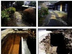
写真 調査状況
