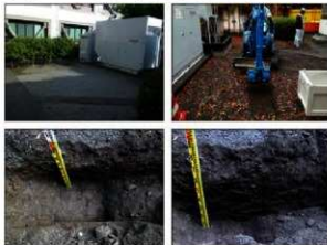
写真 調査状況
