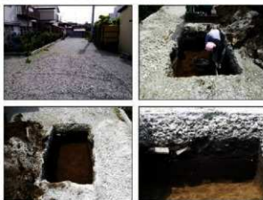
写真 調査状況
