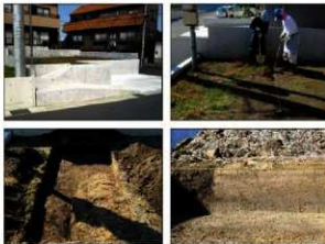
写真 調査状況
