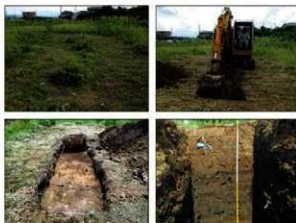
写真 調査状況
