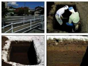
写真 調査状況
