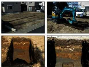
写真 調査状況
