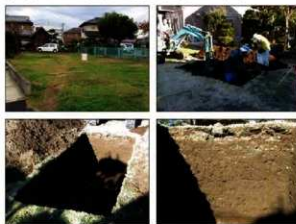
写真 調査状況
