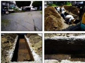
写真 調査状況
