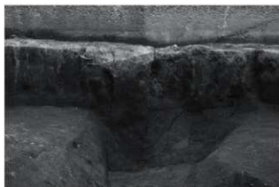
1-SX115 断面 (西から)
