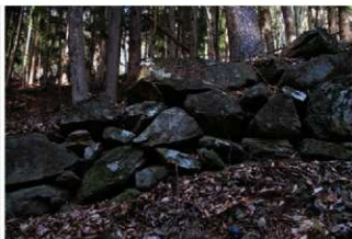
石積 15 傾斜変換点における築石の状況
