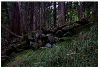
石積 15 西端部築石の状況 (縦石使い)
