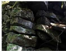
図7 青柳城跡主郭石積の控積み
