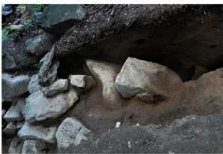
石積6 (トレンチ4) 控積みと裏込めの状況
