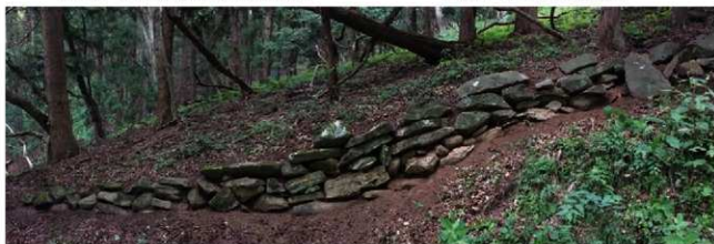
石積 26 南部全景 (平場 J11 西辺)
