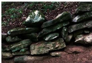
石積 26 根石と石積みみの状況
