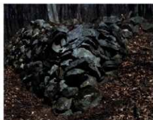
図4 桐原城跡段郭石積の隅角部
