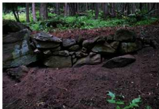
石積 10 石積の状況
