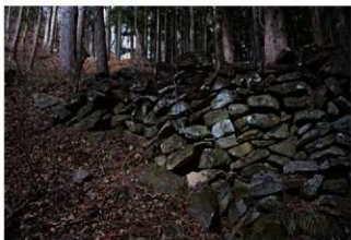
石積 40 石積みの状況（西半）
