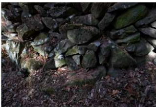
石積 40 根石付近の状況（東半）
