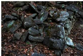
石積3 (トレンチ3) 隅角部の状況
