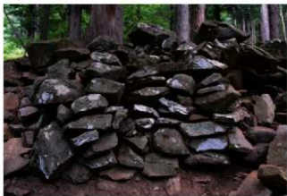
石積 12 (トレンチ 19 西方)
