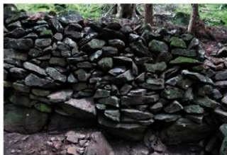
石積 17 西部の根石と石積みみの状況
