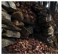
図6 桐原城跡段郭石積の控積み
