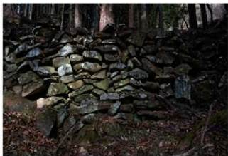
石積 40 石積みの状況（中央）
