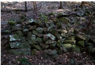
石積 15 南面の石積みと隅角部の状況
