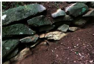
石積 26 根石と石積みみの状況
