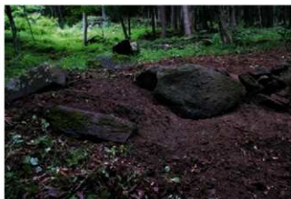
石積10 西端部と土塁10の接続状況
