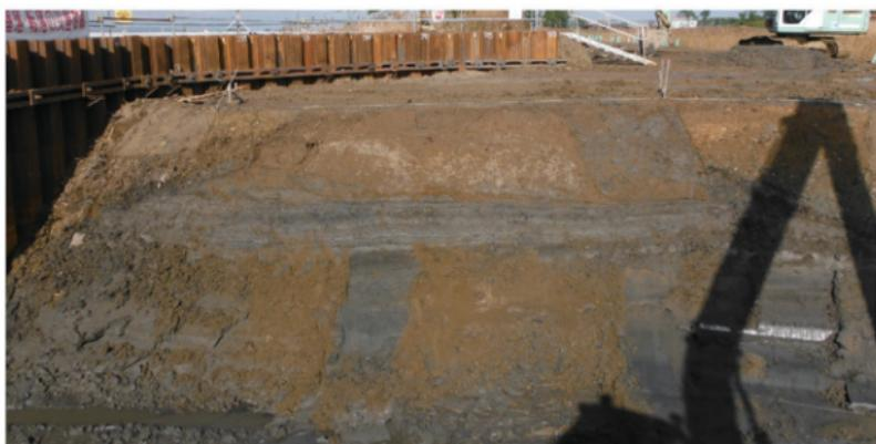
写真14 第2地点の堤防断面（南から）
