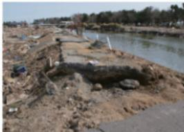
写真2 藤曾根地区 右岸堤防の損壊状況
