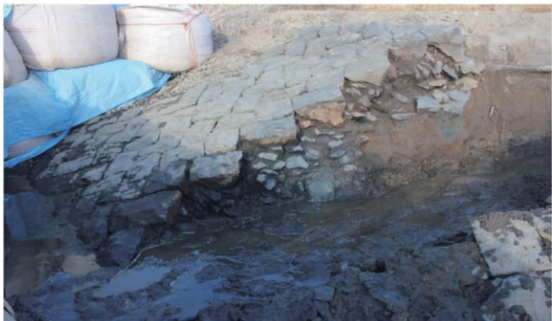
写真12 石積護岸の断面
