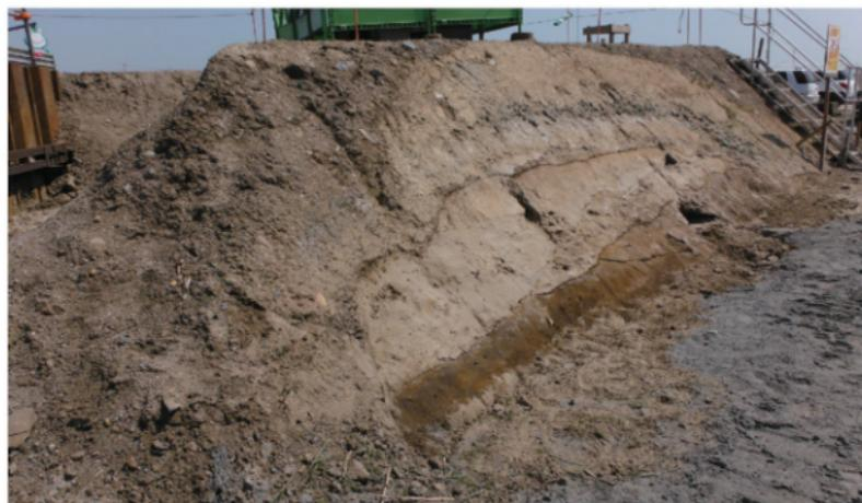
写真21 第9地点の堤防断面（南西から）
