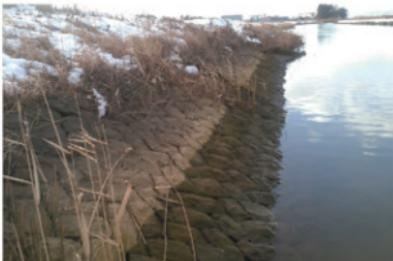
写真7 石積護岸確認状況
