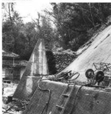
ート面に打込み、施工した。擁壁基礎は地盤耐力の関係から抜地面を広く取り、既製PC杭を打込むことにより、土圧による変位や転倒を防止した。また墓地などに接する後円部西端の擁壁については、掘削範囲が限られるため練石積みによる土留壁として計画した。
