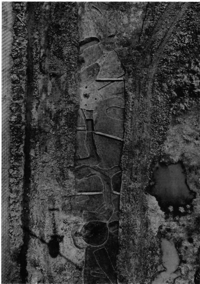
CE2区全景（上空より）
