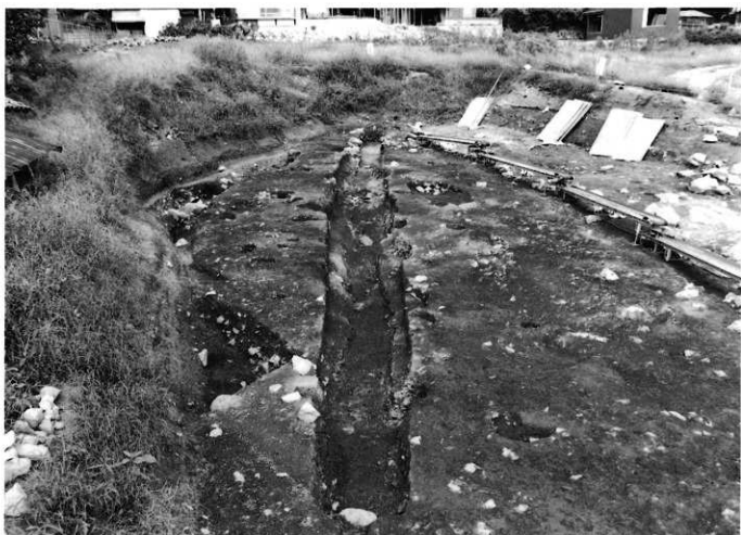
2. 溝2完掘 (南から)
