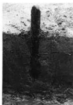
SD02内杭断面
