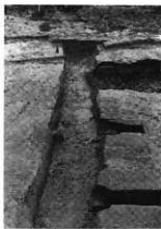
SD03完掘状況
