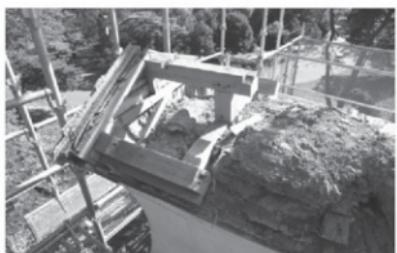
第2211図 南北土壙妻部 軸体部を削り横木を設置
