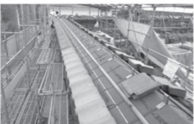
第2345図 屋根工 下地シートと瓦葺き
