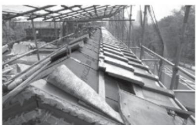
第2346図 屋根工 下地シートと瓦葺き
