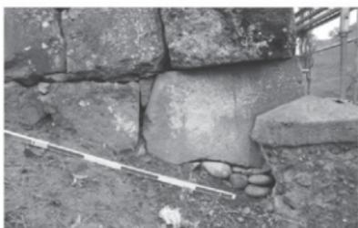
第2191図 3区 D面角石CD-4下に詰石施工
