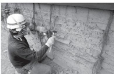
第2333図 土壁工 南北土塙西面 瓦端部のハツリ
