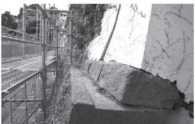
第2305図 北端部天端石の段加工(北から)
