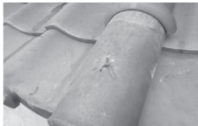
第2350図 瓦工 瓦の銅線留め
