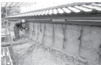
第2332図 土壁工 南北土堀西面 瓦端部のハツリ
