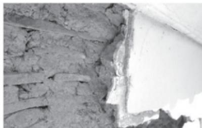
第2012図 被災状況 外壁のモルタル
