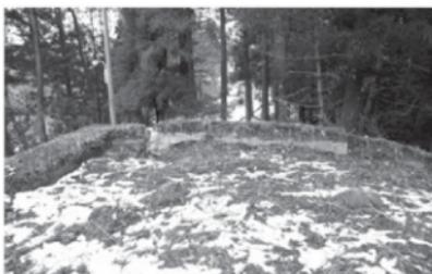
第1521図 天端の沈下(南から)
