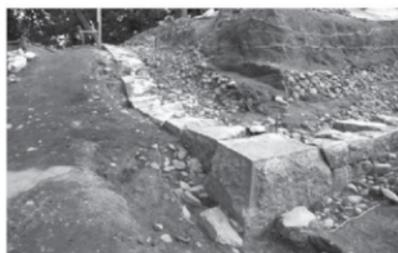
第1733図 C面基部の変形
