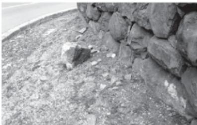
第1872図 C面前面の築石・詰石の落下状況
