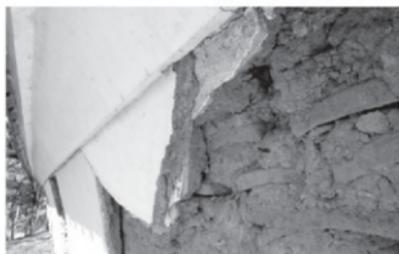
第2011図 被災状況 外壁のモルタル
