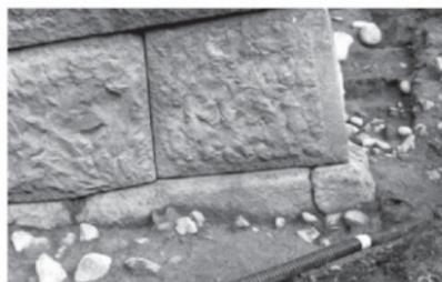
第1764図 AB角石の亀裂(西から)
