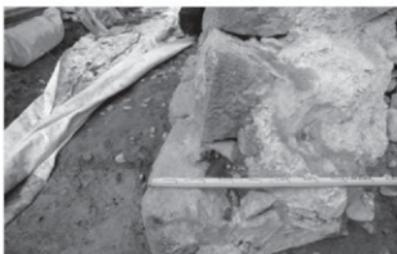
第1584図 石垣断面下段築石のセットバック(南から)
