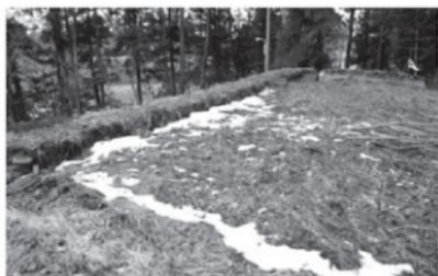
第1520図 天端の沈下(南から)
