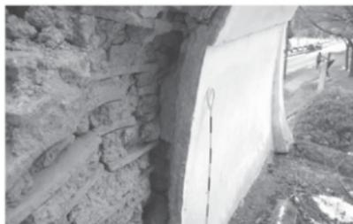
第2013図 被災状況 外壁のモルタル
