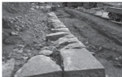
第1721図 B面基部石材の変形
