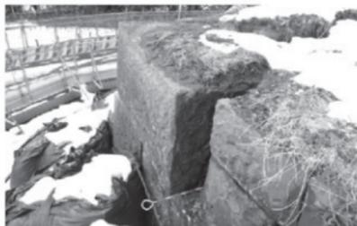
第1508図 AB天端角石のずれ
