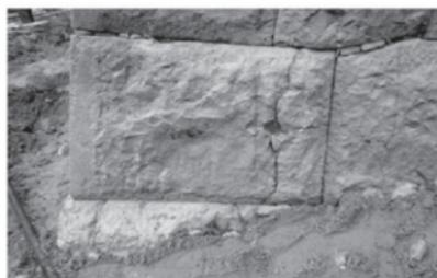
第1767図 AB角石の亀裂接着後(南から)
