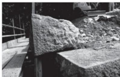
第1590図 C面 築石のずれ
