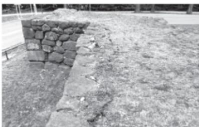
第1878図 A面天端の亀裂(西から)
