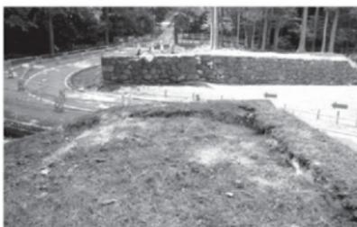
第1519図 天端の沈下(北から)
