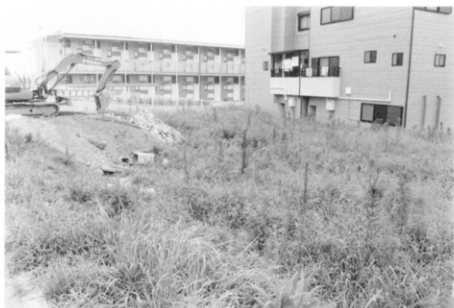
1. 調査前全景 (北から)
