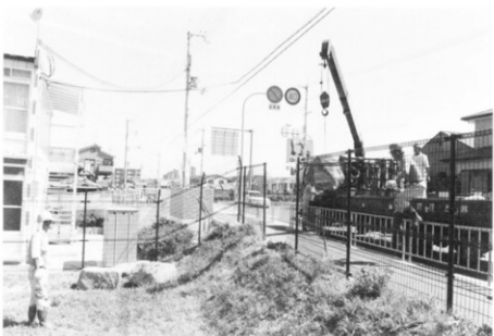
3. 礎石移設作業
