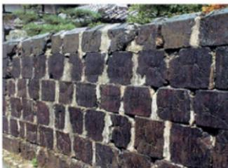
図 11-4 製錬滓を固めたカラミ石による塀
