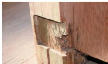
写真 1-6. 柱の床框の痕跡
