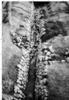
▲内裏東大溝 SD2700。平城宮の排水体系を支える屋台骨である。8が出土した暗渠 SD2000も、この大溝に流れ込んでいる。(北から)
