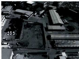
工業棟 近景 (北西から)
