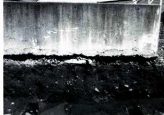
調査区東壁 セクション④ (北西から)
