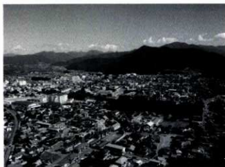
工業棟 遠景 (西から)
