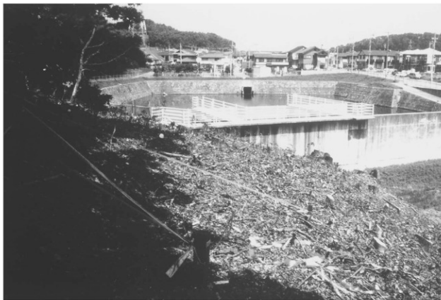
写真 39 北地区2調査前（南から）
