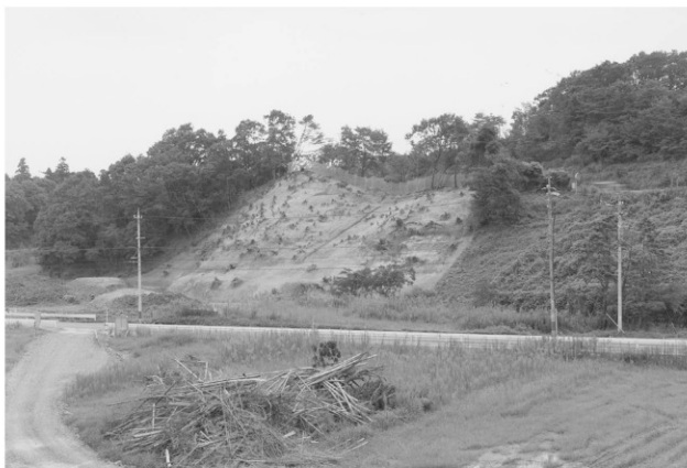
写真 5 東地区調査後（北東から）
