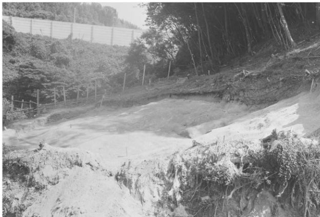
写真 40 北地区2調査後（北西から）
