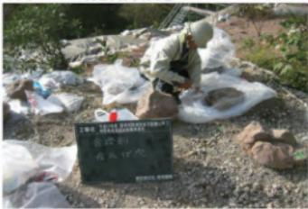
写真 39 石材薬材含浸状況①
