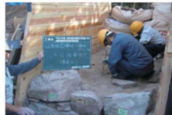
写真 52 土石層つき固め状況
