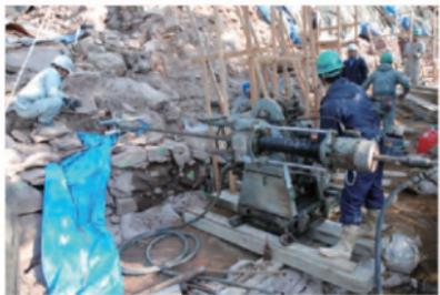
写真 151 排水補強パイプ掘削状況 (北西から)
