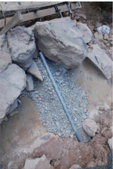
写真 152 排水補強パイプ設置状況① (南東から)
