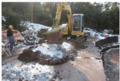
写真 137 酸化マグネシウム攪拌状況 (北から)
