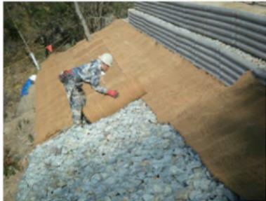
写真 177 ヤシ系マット施工状況 (南から)
