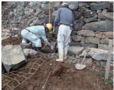
写真 179 城壁根固め状況 (南西から)
