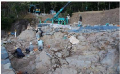
写真 155 壱城石積み撤去状況（南西から）
