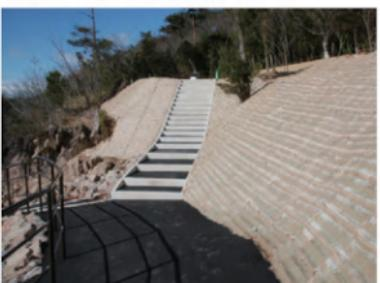
写真 202 植生マット設置完了状況（南から）
