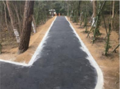
写真 220 見学路①基層舗装状況（南から）
