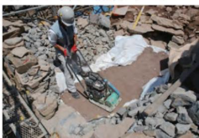
写真 113 下地設置状況 (南西から)
