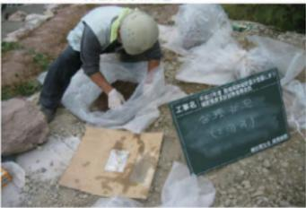
写真 40 石材薬材含浸状況②
