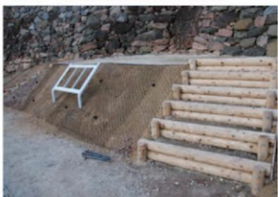
写真 182 土舗装2ラス網設置状況 (南西から)
