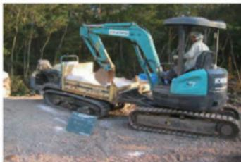
写真 51 酸化マグネシウム攪拌状況
