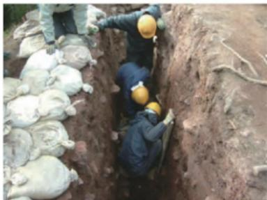
写真 28 サンプリング用板材設置状況
