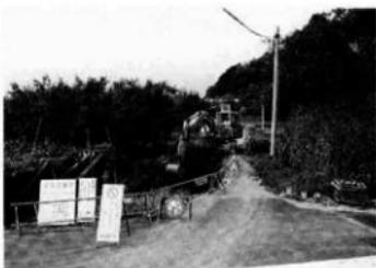
写真2 A区重機による表土剥ぎ
