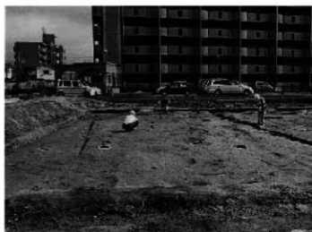
2. 作業風景（北より）
