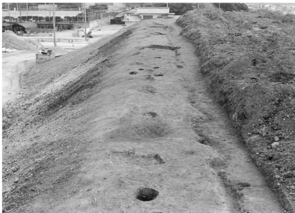
1 発掘完了A区北側（北西から）
