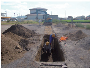
写真2 試掘調査風景(西から)
