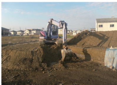
写真1 重機掘削の様子(北東から)
