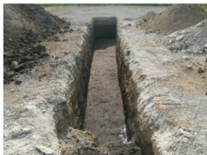
写真5 3トレンチ 全景(東から)
