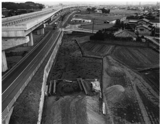
第15回 飯氏道路第6次第1地点道路西半区全景（東から）
