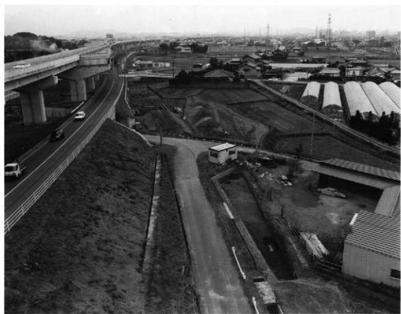
第14回 飯氏道路第6次第1地点道路調査区道景（東から）
