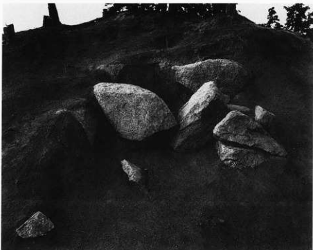
1. 巨勢山323号墳 羨道部天井石陥落状況（南から）
