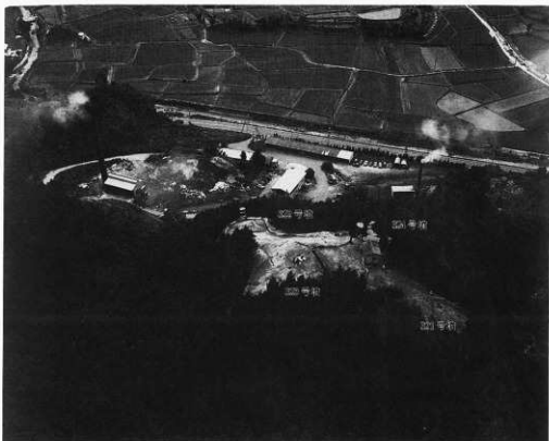
1. 第一次調査地航空写真（東から）
