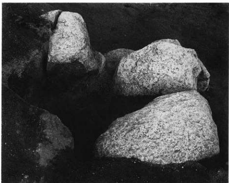
2. 巨勢山323号墳 羨道部天井石陥落状況（西から）
