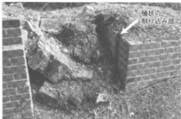
図6 橋台溝状部分の詳細（南西より）
