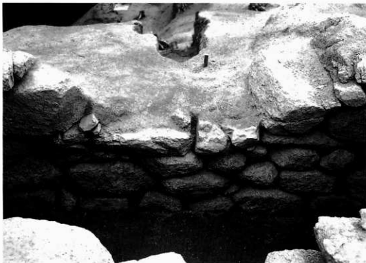
巨勢山407号墳 石室（玄室右側壁）
