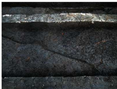
S K X 2161盛土単位(西一) S X 2141盛土整地地業の硬化面にも軟質な部分がある。硬化部を取り巻く軟質部がセットになって盛土 1 単位を形成している。軟質部底面に植物遺体が多く含まれていた。
