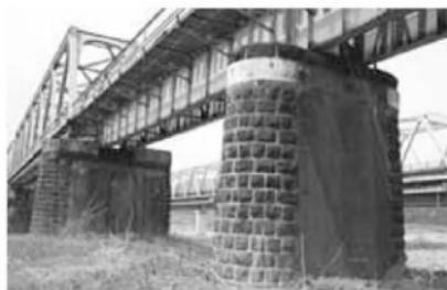
写真16 第一最上川橋梁 規模の異なる2種類の橋脚
