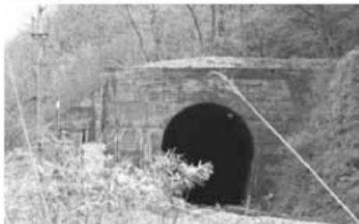
写真4 板敷山隧道（余目方）山側の下部に煉瓦部分が残る。
