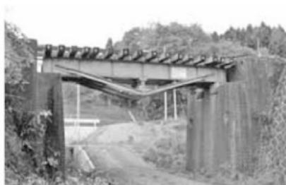
写真14 界川橋梁 (南から) フィンク補強の橋桁
