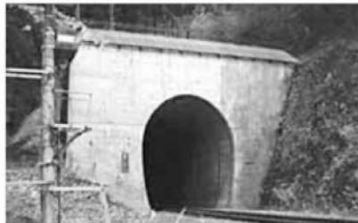
写真5 酒噭隧道（余目方）北側側面に煉瓦部分が残る。
