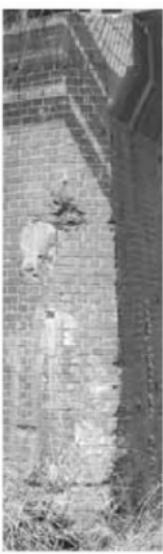
写真32 内又架道橋 橋台 開口部の切り落し面に見られる装飾的な煉瓦積み (左・余目方、右・新庄方)
