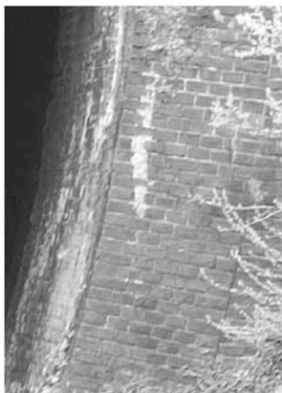
写真27 板敷山隧道余目方坑門側壁部の「化粧追持」
