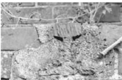
写真13 (旧) 名称未確認架道橋 橋台 廃レール埋め込み状況
