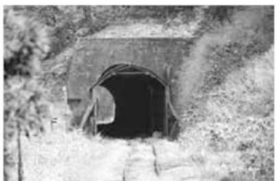
写真7 第二高屋隧道（余目方）雪崩除け付き
